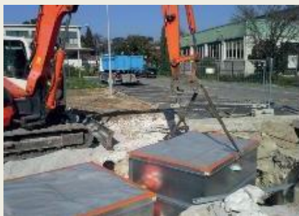
Einbau des Metalltanks In vorbereitete Baugrube
