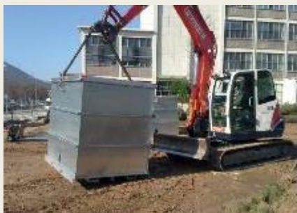
Handhabung des Metallbehälters mit Hilfe eines Baggerladers
