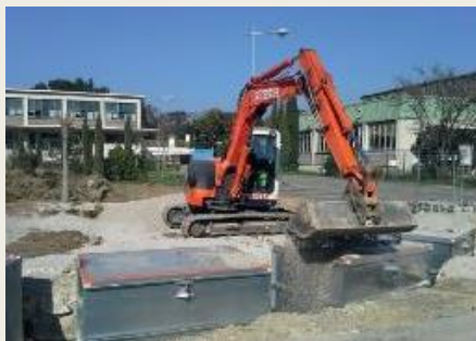
Befüllung und Umrandungsarbeiten (gemäß Installationsanleitung)
